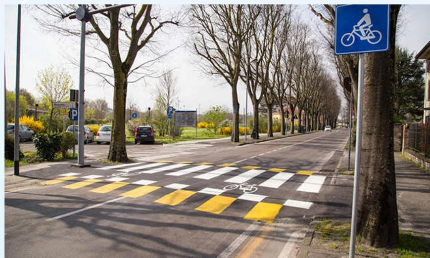
Le pendenze e le lunghezze vanno mediate con le caratteristiche della strada e del traffico.
